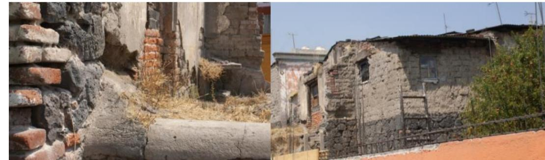
Ilustración 107. Construcción de adobe y roca basáltica. Barrio La Candelaria.
